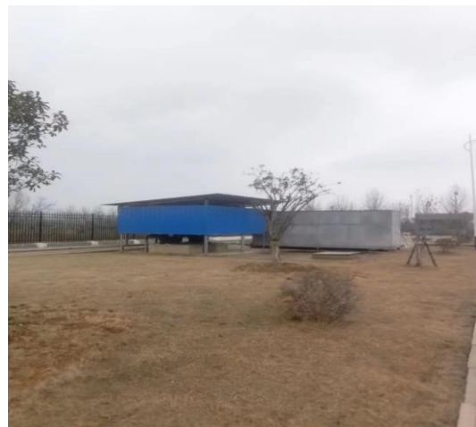
应急事故池及初期雨水池（均为地埋式）
