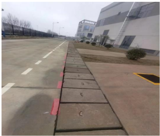
雨水排放沟渠（明渠）
